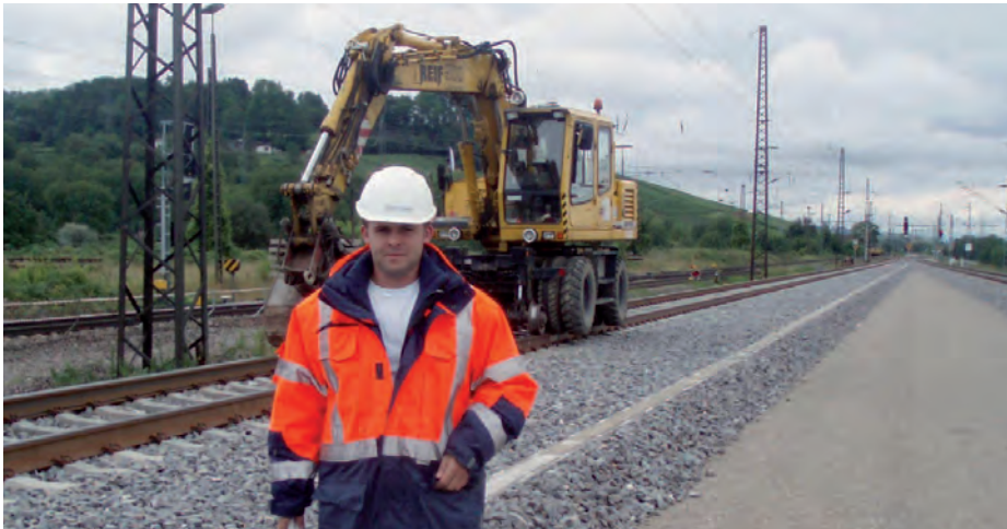
Bauüberwacher Torsten Haas in „seinem“ Abschnitt nördlich des Katzenbergtunnels
